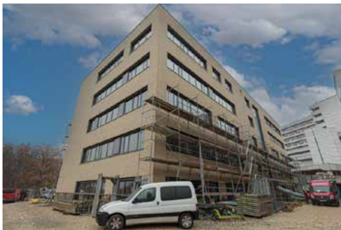
Abbau des Gerüsts am neuen Ärztehaus; Foto: ALB FILS KLINIKEN / Max Radloff
